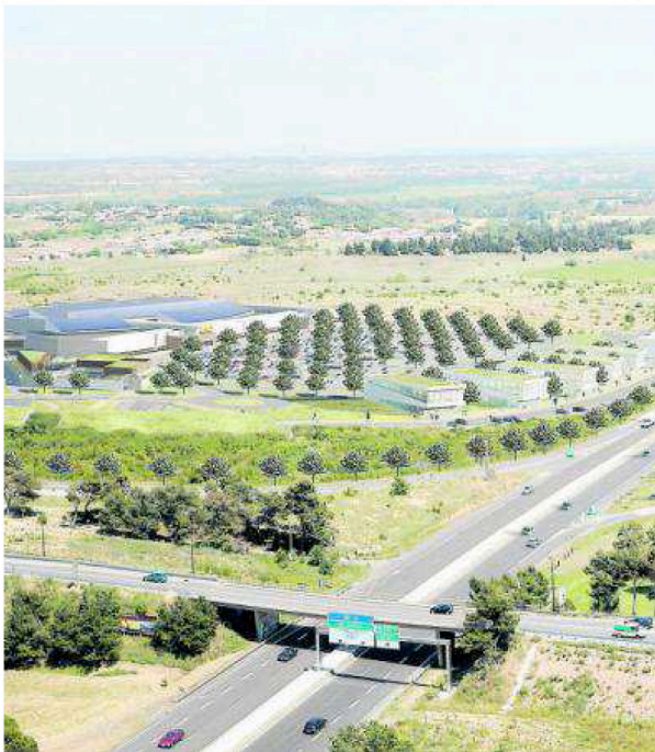
La nouvelle vue du programme Rocadest avec l'ensemble immobilier en bordure de RD 6113.
